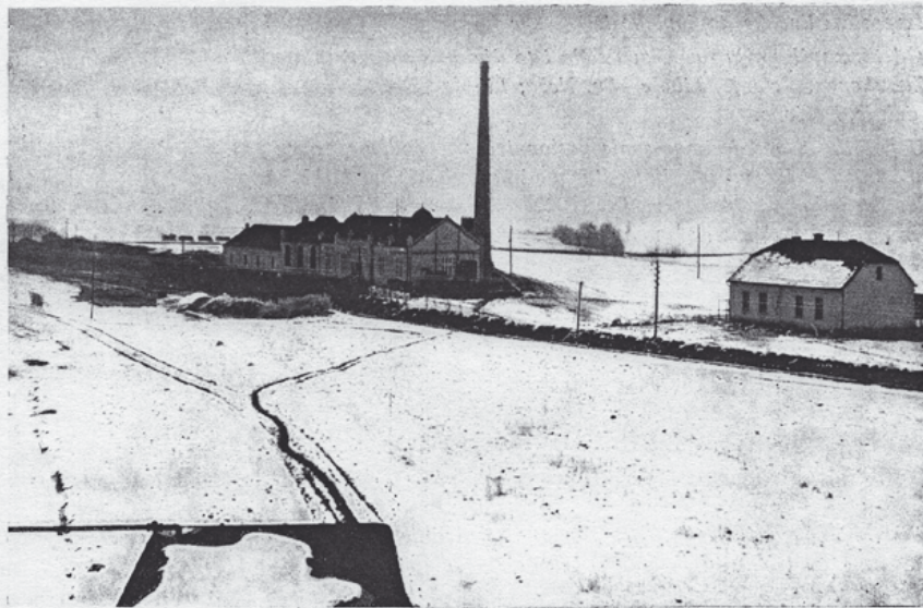
Pogled na strojarnicu iz daljine
